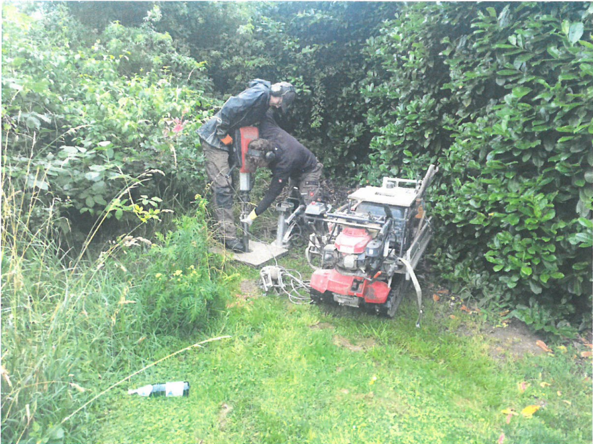
Bild 3: Ausführung RKS 1 am 01.07.2021 mit örtlicher Situation
