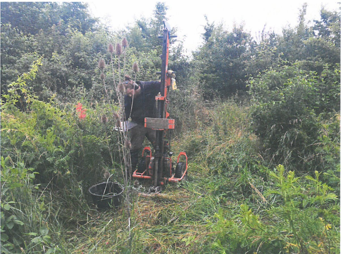
Bild 4: Ausführung DPH 1 am 01.07.2021 mit örtlicher Situation
