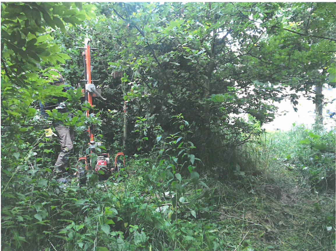
Bild 6: Ausführung DPH 3 am 01.07.2021 mit örtlicher Situation
