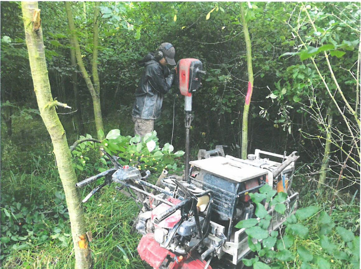
Bild 8: Ausführung RKS 2 am 01.07.2021 mit örtlicher Situation
