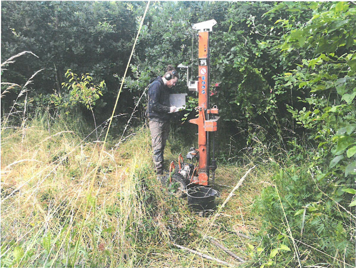
Bild 7: Ausführung DPH 2 am 01.07.2021 mit örtlicher Situation
